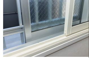
全住戸の内窓設置を実施
